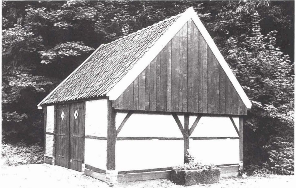
Het fraai gerestaureerde vakwerkgebouwtje op het landgoed.
